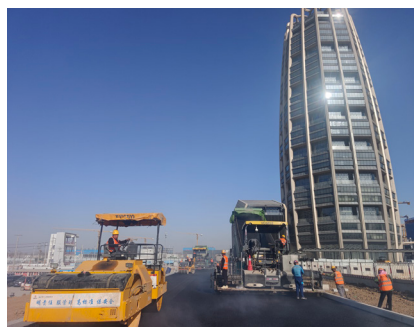
01 雄安项目现场施工
