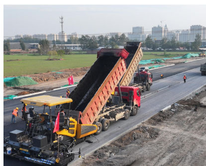
03 邢台项目施工
